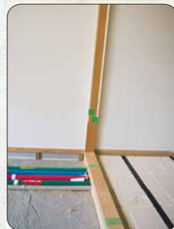
使用養生材：①ベニア ②カットエース コメント：敷居にベニアを用いたオーソドックスな養生。
