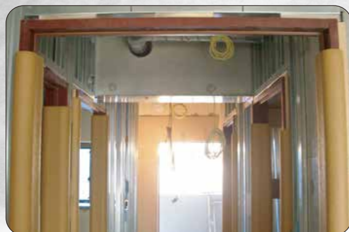
使用養生材：①ミナキーパー(K120) コメント：木枠にはめ込むだけの養生方法で、繰り返し使用できます。
