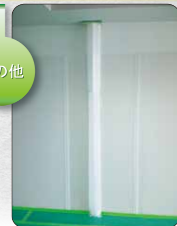
使用養生材：①ブラダン(白) ②カットエース コメント：ブラダンをカットして丸め、カットエースで固定。壁養生板の抑えとして利用します。
