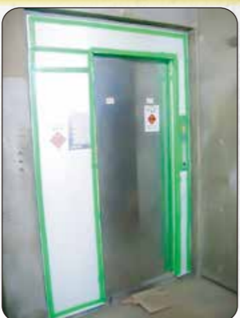
使用養生材：①ブラダン ②カットエース ③SPVテープ(表面保護) コメント：ブラダンをカット、カットエースで固定しています。
