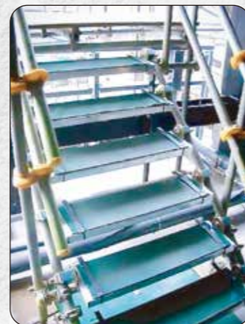
使用養生材： ①塩ビシート(B山) コメント：シートをカットし、ゴムテープで固定しています。
