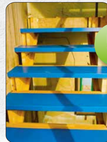
使用養生材： ①青階段 コメント：青階段は、適当な大きさにカット、段差部分に設置し、テープで固定しています。
