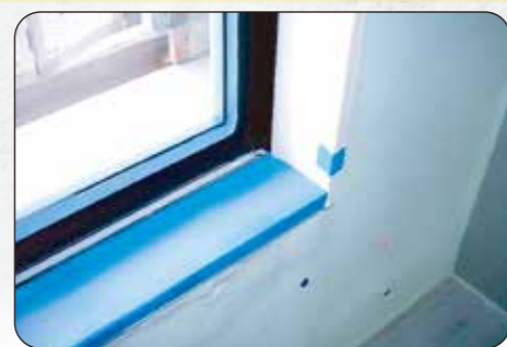
使用養生材：①ブラダン 青 コメント：ブラダン(青)をカットし、和紙テープで固定しています。
