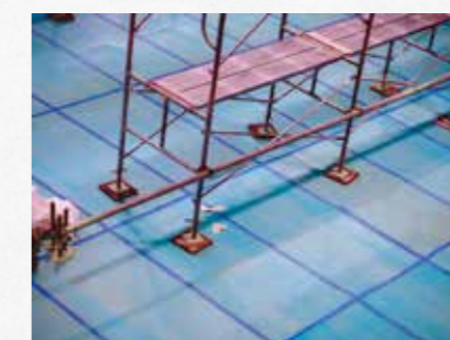
ガード板養生の上に足場を組んだ様子
