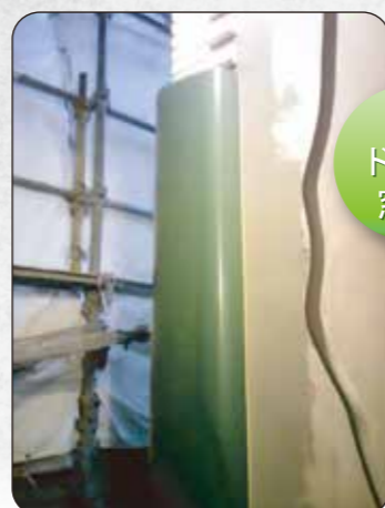
使用養生材：①フリーサイズ養生カバー コメント：柱にはめ込むだけの簡単な養生です。
