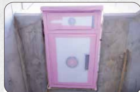
使用養生材：①ブラダン(白) ②ポリエチレンフィルムテープ(さくら色) コメント：ブラダンをカットし、さくらテープで固定しています。
