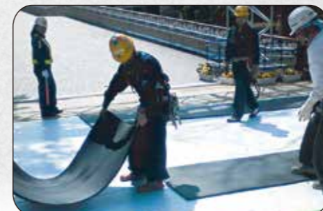
使用養生材：①ブラックターフ コメント：屋外の通路養生。自重の重さで固定できるため、敷くだけで設置が完了します。
