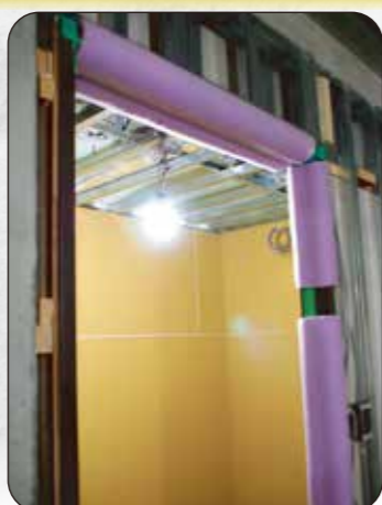
使用養生材：①ソフトブロック コメント：はめ込み式の養生で、繰り返し使用できます。
