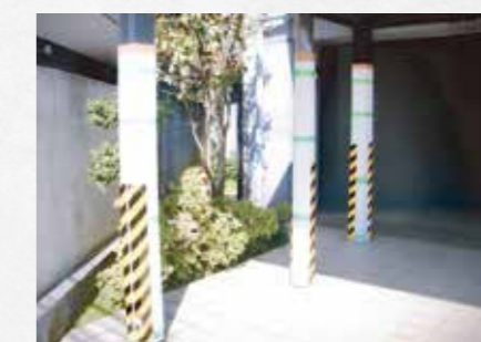
柱にブラダン養生を施した様子
