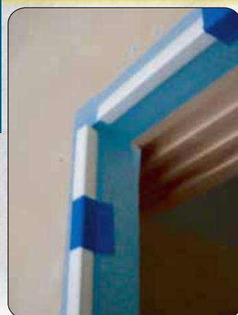
使用養生材：①コーナーアングル ②和紙テープ ③クロスロン コメント：捨て張りで和紙テープを貼った上にコーナーアングルを固定します。
