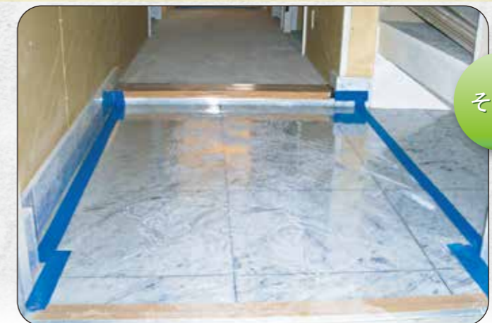
使用養生材： ①タフニール ②ビニールシート ③クロスロンテープ コメント：見せる養生として使用しました。透明のシートなので、傷が付きやすい場所など特定しやすくなりました。
