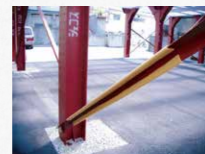
鉄筋柱にソフトブロックカバーを装着
