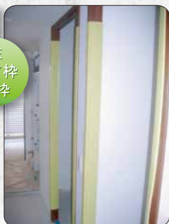
使用養生材：①ドア枠養生カバー コメント：ドア枠にはめ込むだけの養生方法で、繰り返し使用できます。
