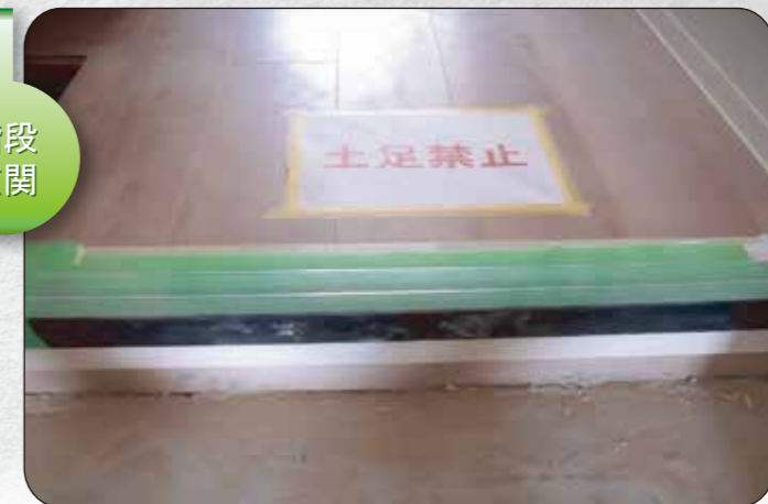
使用養生材：①和紙テープ ②コーナーアングル ③ポリエチレンクロステープ コメント：テープとコーナーアングルを使った簡単な養生です。実際は、ダンアングルを使うのが好ましいでしょう。
